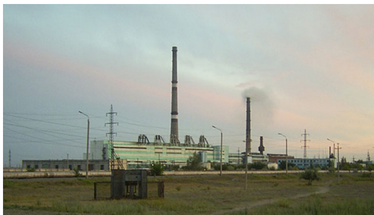
Figure 3 – The Ekibastuz CHP of TOO Ekibastuzteploenergo ( https://ru.wikipedia.org/wiki )
